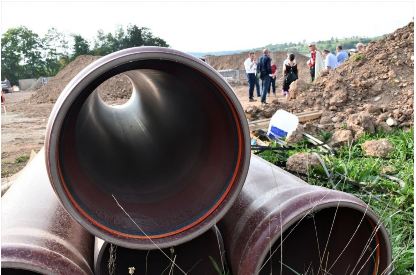
BZ-Hautnah dabei: auf der Baustelle des neuen Zentralklinikums Foto: Barbara Ruda
